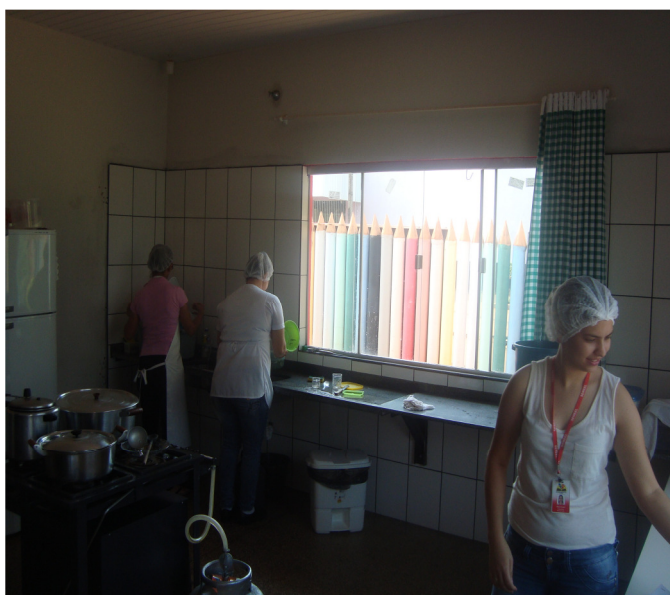
Foto 07 - Janela aberta, sem tela de proteção (item 4.1.4 da Resolução-RDC Anvisa 216/2004), possibilitando entrada de poeira, insetos e roedores. Colíder (MT), 01/09/2016. Creche Gustavo Guarani
