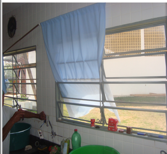
Foto 08 - Janela aberta, sem tela de proteção (item 4.1.4 da Resolução-RDC Anvisa 216/2004), possibilitando entrada de poeira, insetos e roedores. Colíder (MT), 01/09/2016. Escola São Mateus
