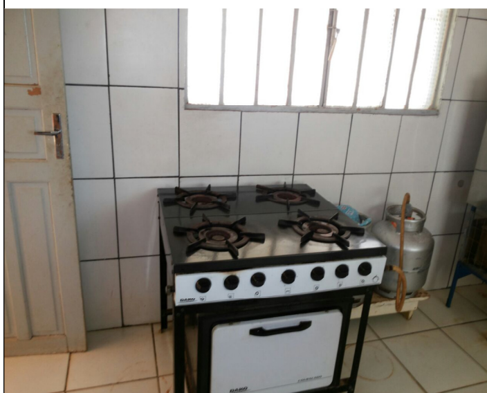
Foto 03 – Botijão de gás na cozinha (sem abrigo na parte exterior da edificação – NBR 13523) e inexistência de azulejo até o teto (item 4.1.3 da Resolução-RDC Anvisa 216/2004), Colíder (MT), 01/09/2016 Esc. .N. Sra Perpétuo Socorro
