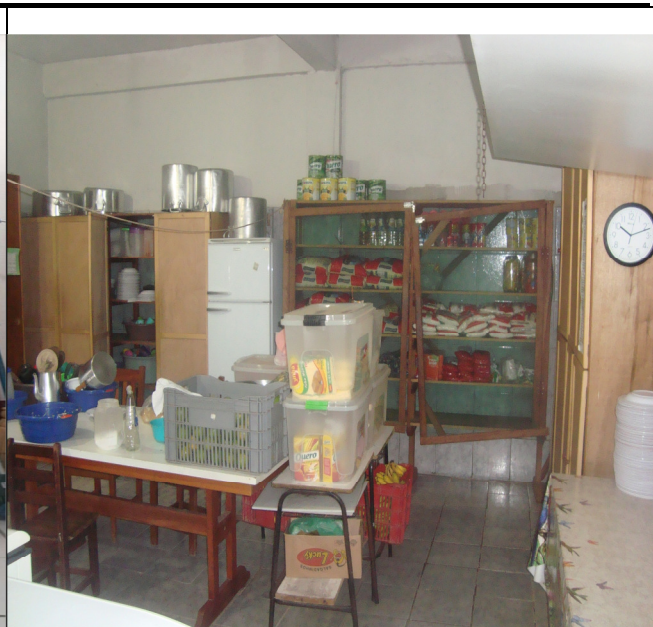
Foto 02– Armazenamento inadequado de gêneros alimentícios (item 4.2.4 da Resolução-RDC Anvisa 216/2004), ) e inexistência de azulejo até o teto (item 4.1.3 da Resolução-RDC Anvisa 216/2004) Colíder (MT), 01/09/2016. Esc. Atalaia
