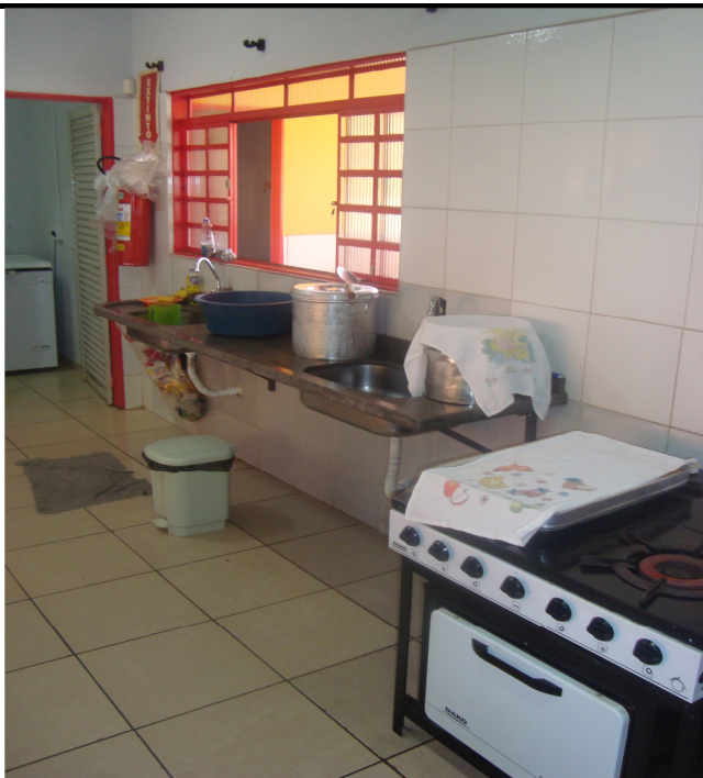
Foto 11 – Janela aberta, sem tela de proteção (item 4.1.4 da Resolução-RDC Anvisa 216/2004), possibilitando entrada de poeira, insetos e roedores. Colíder (MT), 01/09/2016. Creche Santa Bernadete
